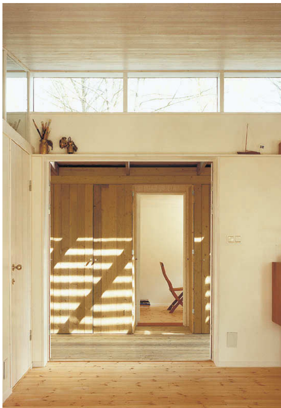
Invändiga väggar av limmad golvspånskiva. Golv av massiv furu som oljats och polerats.
