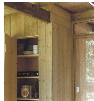
Bärande stomme av trä. Slåtpontad järnvitriolbehandlad panel utvändigt.
