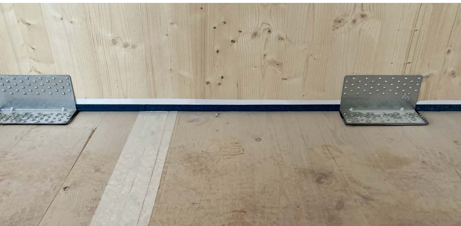
Tejpad skarv mellan bjälklags-element samt anslutning mellan bjälklag och vägg.
