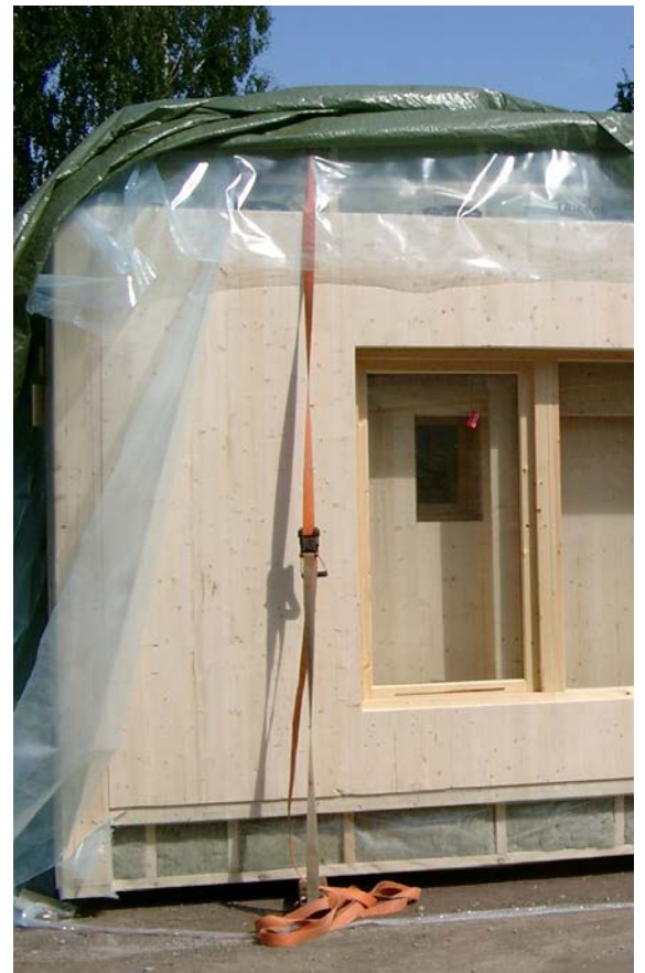
Figur 5 Prefabricerade väggelement på väg att avtäckas i samband med montage.
