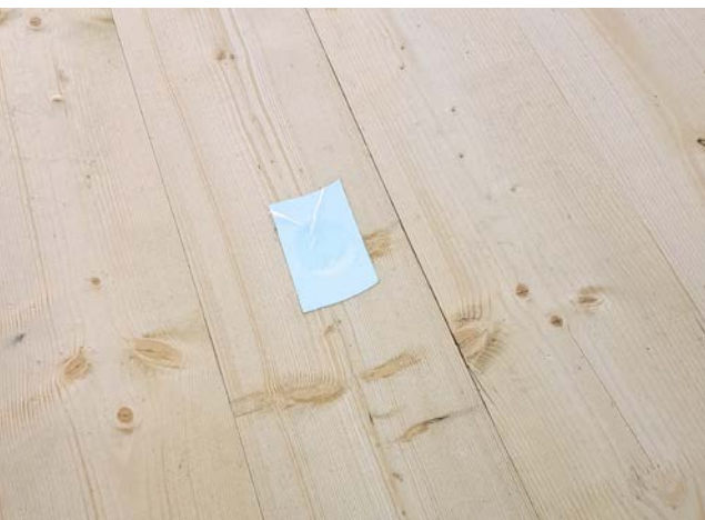
Tätning av mindre hål med tejp.
