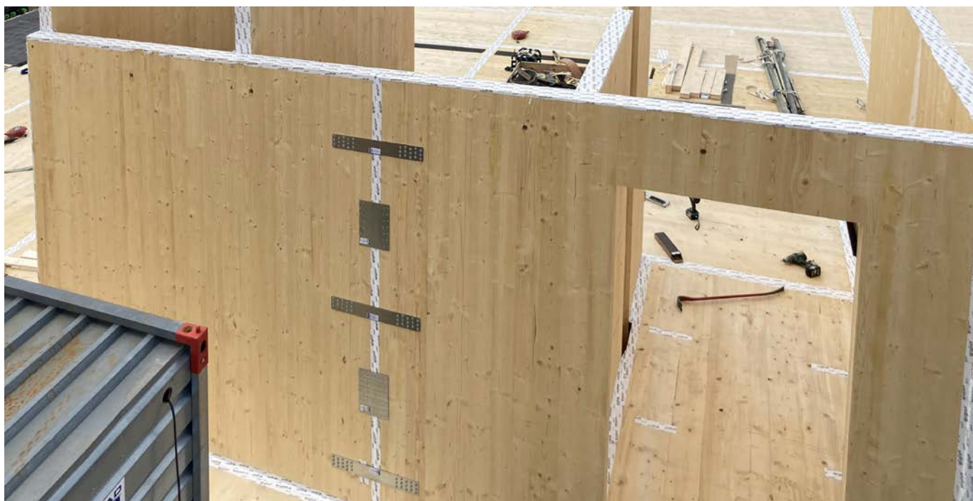
Exempel på hur KL-träelement skyddas med tejp under montage.
