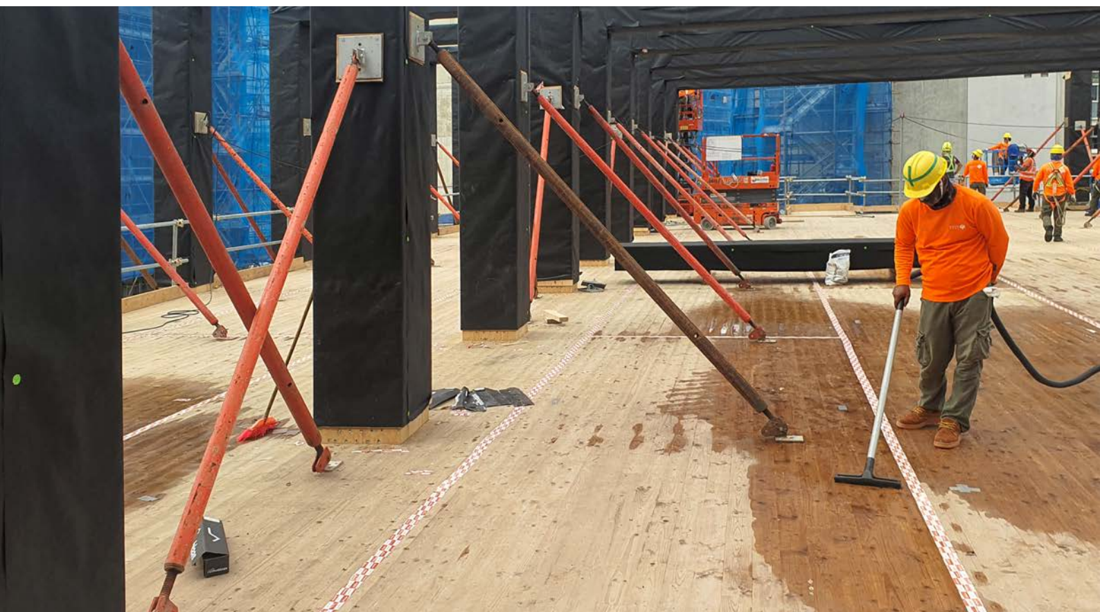
Våtdammsugning av bjälklag.
