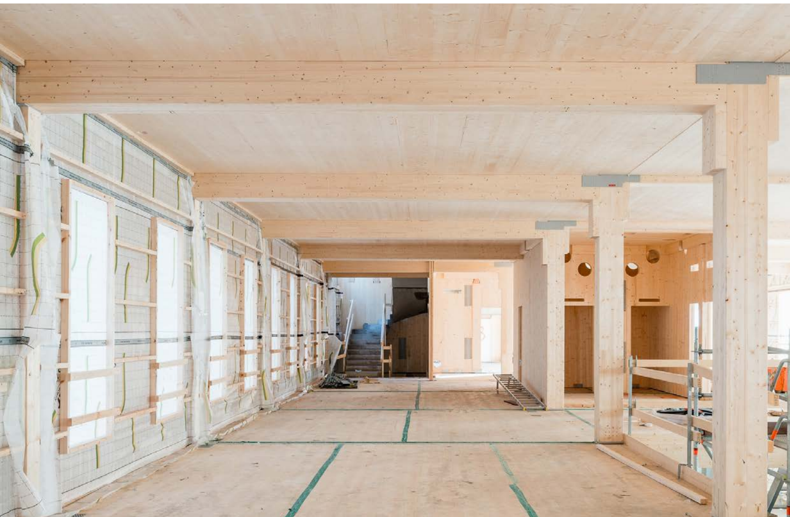
Pågående byggprojekt i KL-trä.
