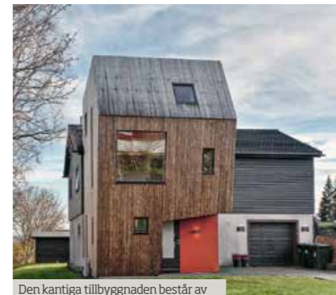
Den kantiga tillbyggnaden består av trettio centimeter tjocka väggar och ett halvmeter tjockt tak.
