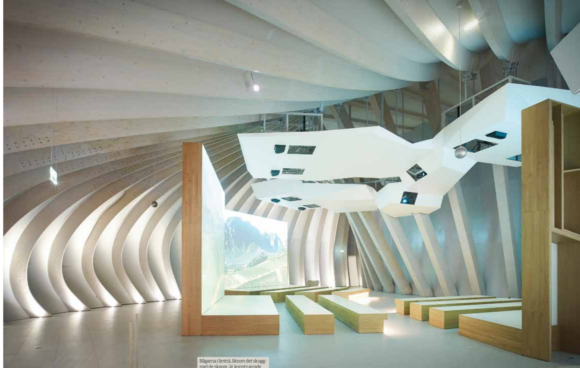
Museets limträkonstruktion med sina böjande bågar är inspirerad av fartygsanatomi, vilket ger en tydlig länk mellan land och vatten.
