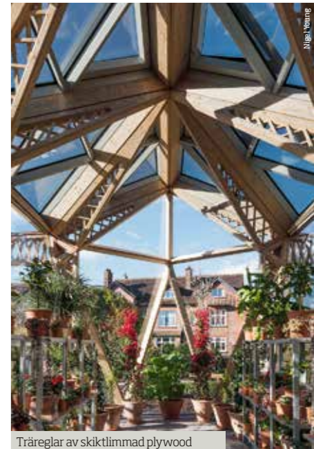
Träreglar av skiktlimmad plywood bildar tillsammans korsstag vilket ger en stark konstruktion.
