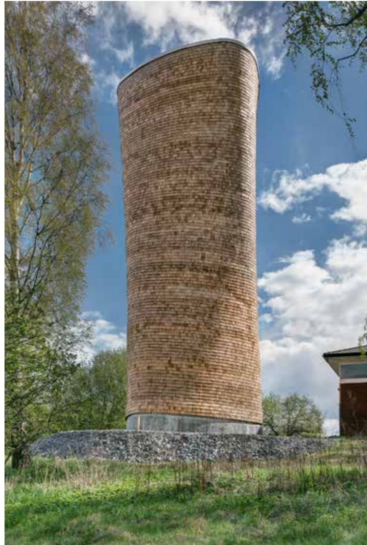
Fig 1 Avluftningstorn i Lill-Janssskogen, Stockholm, av Rundquist Arkitekter.
