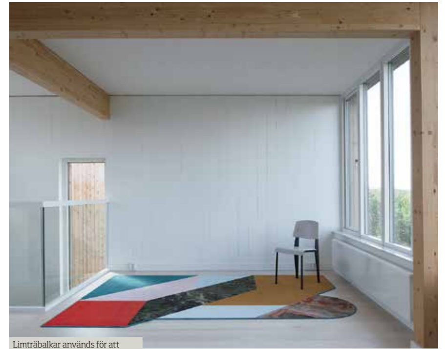
Limträbalkar används för att stärka upp konstruktionen för spännvidder över 5,5 meter.
