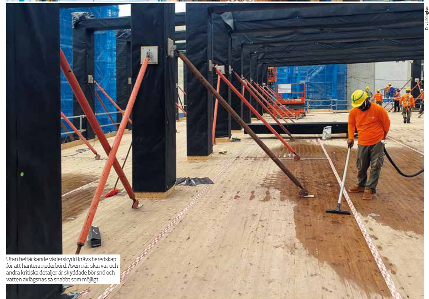
Heltäckande väderskydd ger ett gott skydd mot fuktskador och minskar risken för störningar orsakade av vädret under byggprocessen.
