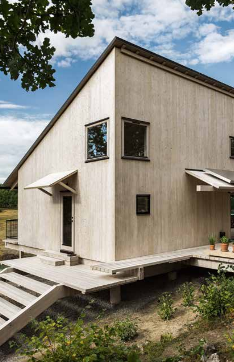
Eftersom väggarna är oisolerade har KL-träet inte klätts med panel. Istället är ytan kiselbehandlad. Interiören är behandlad med såpa.
