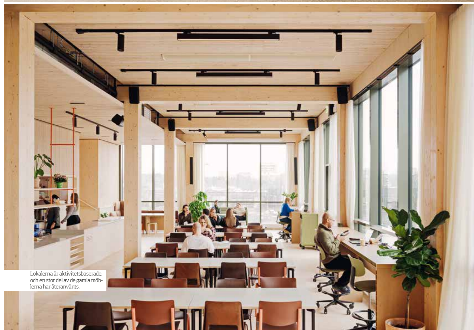
Konstruktionens pelar-balk-system bygger på äldre träteknik som har industrialiserats.
